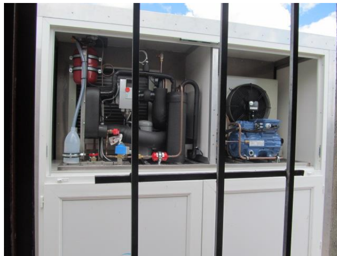
Equipo para generación de agua en humedad de zonas rurales desérticas (Zacatecas)
