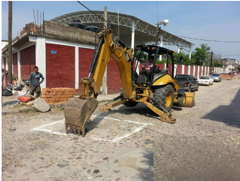
EXCAVACION DE CAJAS
