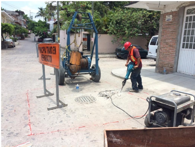
EXCAVACION DE CAJAS
