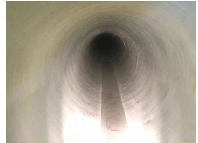
COLECTOR REHABILITADO
